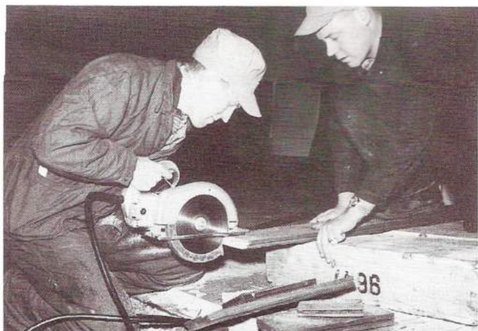
Deckenausbau mit Weichpavatex auf Lattenroste.
